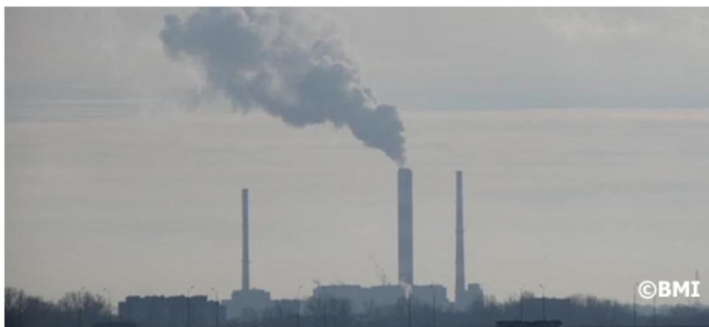
Central termoeléctrica de carbón en Varsovia, Polonia.
