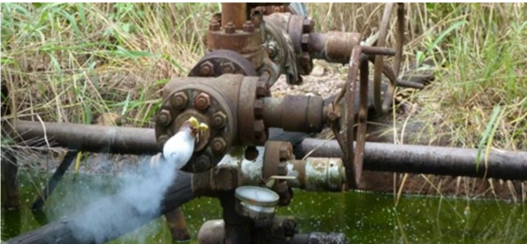
Instalación para la extracción de hidrocarburos; foto cortesía cedib.
