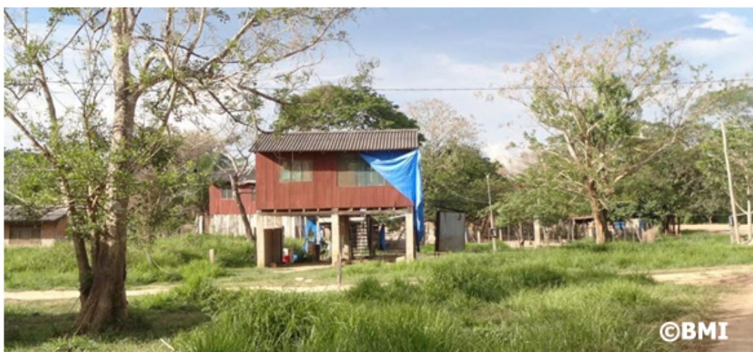
Casas nuevas en pilotes en el Beni
