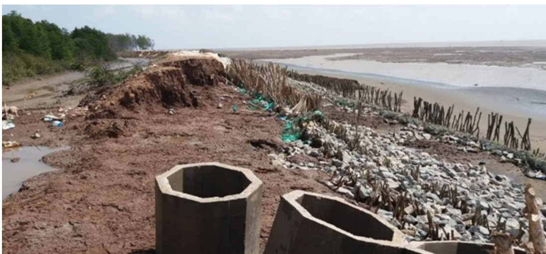
Reparación de un dique erosionado. Foto: cortesía de Roman Sorgenfrei
