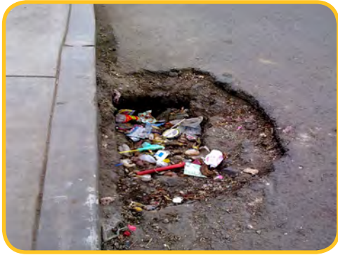
Mal uso de drenaje pluvial, El Alto
