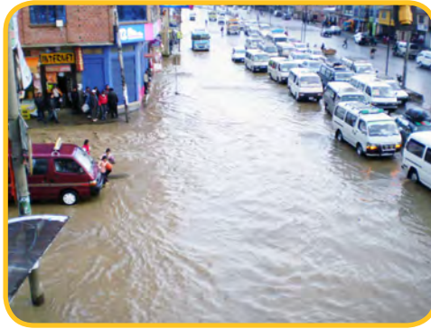
Baja cobertura y mal uso del drenaje pluvial, El Alto
