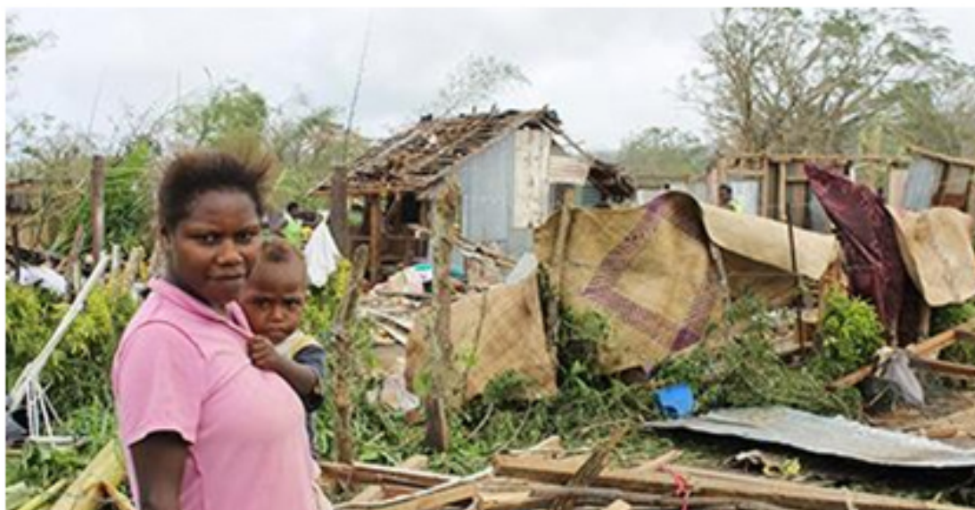
Casas destruidas por el ciclón “Pam” en Vanuatu; foto: UNICEF Pacific
